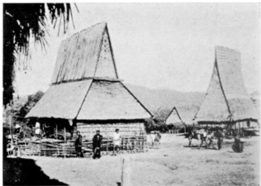
Planche XX. Fig. 3. — Les deux maisons communes de Dak Co (Sedang Dak To). On ne trouve que chez les Sedang des maisons communes à toiture à double pente et encore sont -elles très rares.
